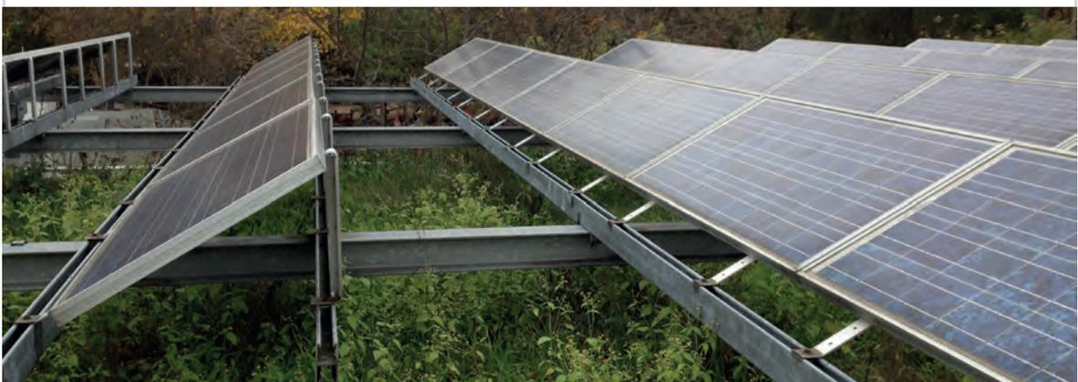
Abb. A6.1: Photovoltaikanlage auf begrüntem Dach
